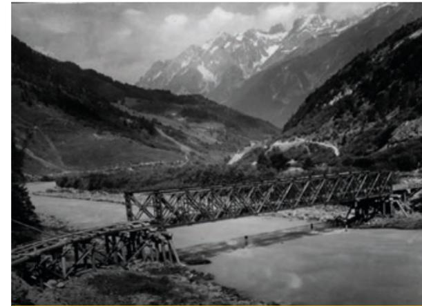
Behelfsmäßige Eisenbahnbrücke über den Inn bei Fließ
